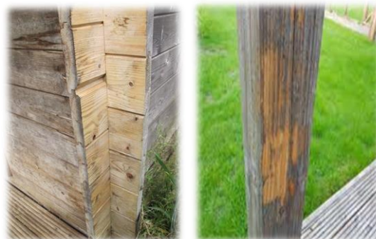
Onvoldoend laagdikte aangebracht
